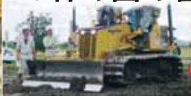
TS・GPSを用いた盛土 の締め固め管理
